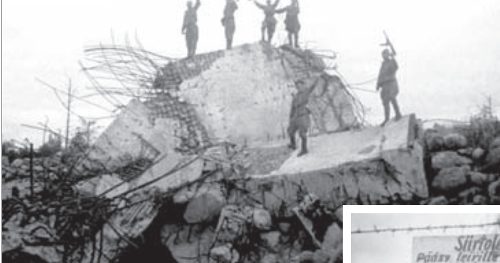
Советские бойцы у разрушенного дота.
