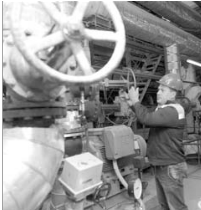
📷 В считанные дни будут завершены работы в жилом фонде, котельных, на теплосетях, линиях газа и электроснабжения.
