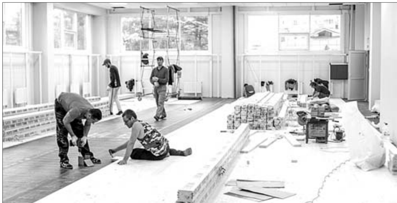
📷 Два этажа здоровья: завершения строительства спорткомплекса на ул. 70-летия Октября, 10/1 с нетерпением ожидают многие жители Юбилейного микрорайона. Ход ремонтных работ оценил Борис Тихоненко.
